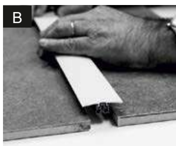
Placer le profil Bevestig het profiel
