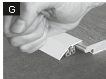
Fixer le profil avec soin et progressivement Bevestig het profiel voorzichtig en geleidelijk
