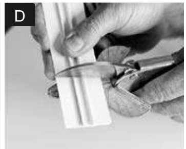
Couper le profil et la base Knip beide profielen op maat
