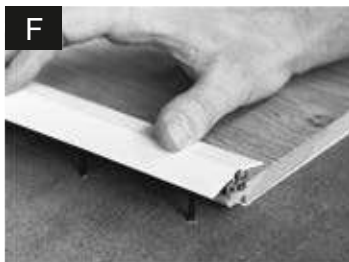
Insérer les vis dans les trous Bevestig de schroef
